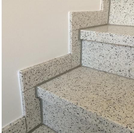
Im Bereich von Treppenanlagen wird der Sockel wandseitig als Steh- und Längssockel angebracht. Die Verbindung beider kann als stumpfer Stoß oder auf Gehrung gesägt erfolgen.
